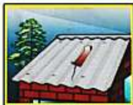
Reparación de tejas y láminas de fibrocemento
